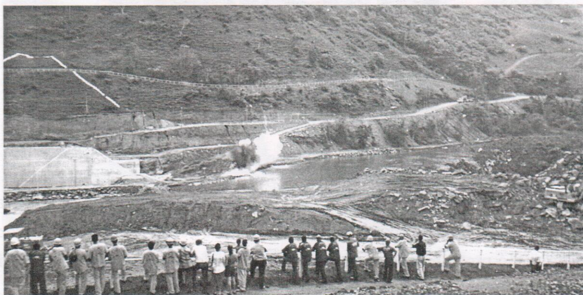
Figura 64: desvio do curso do Rio Doce para a construção da represa.
