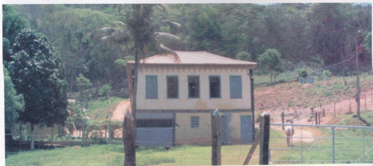
Figura 43: Fazenda Córrego da Onça.
